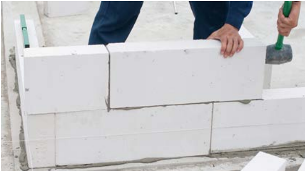
Hình 2. Thi công tường bằng gạch bê tông bọt.
