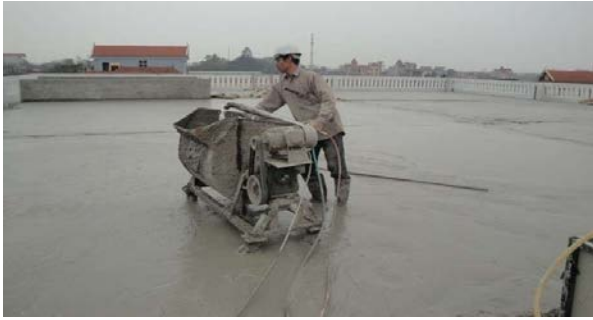
Hình 1. Thi công chống nóng bê tông bọt.
