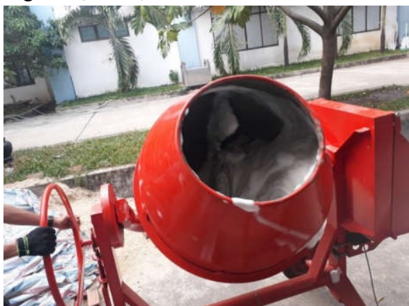
Hình 8. Trộn hỗn hợp bê tông bọt.
