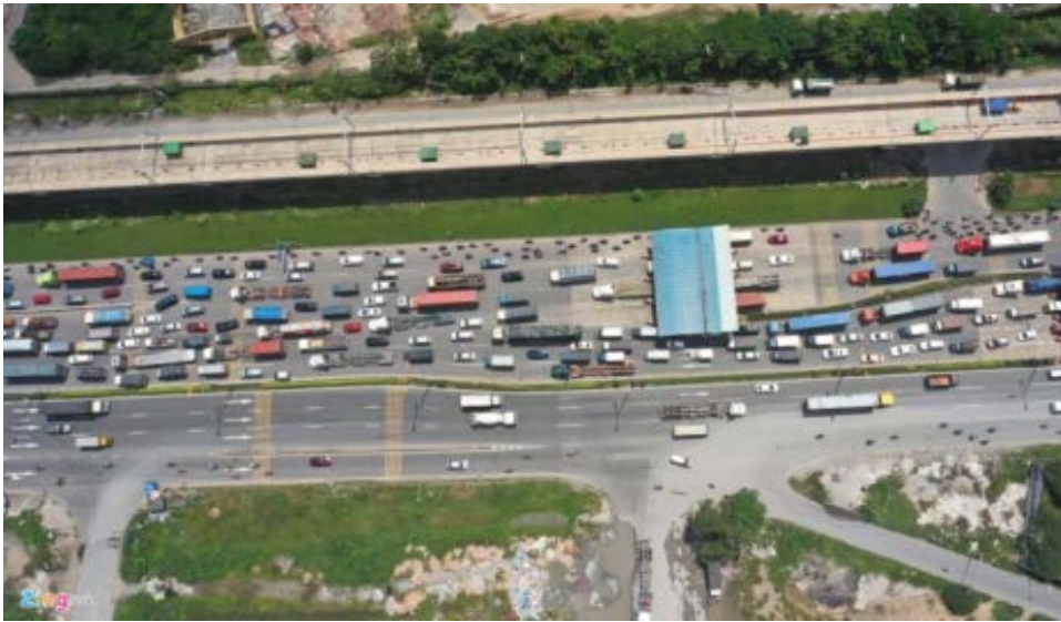
Hình 2. Tình trạng ùn tắc kéo dài tại trạm.
