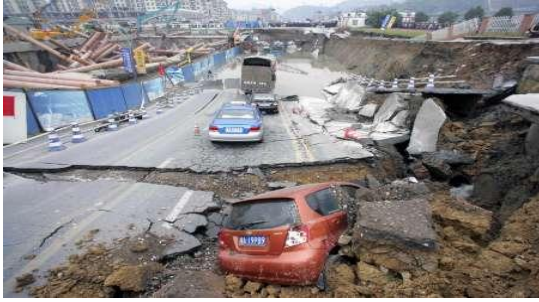
Hình 1. Sập hầm tuyến tàu điện ngầm số 1 ở thành phố Hàng Châu, Trung Quốc [11].
