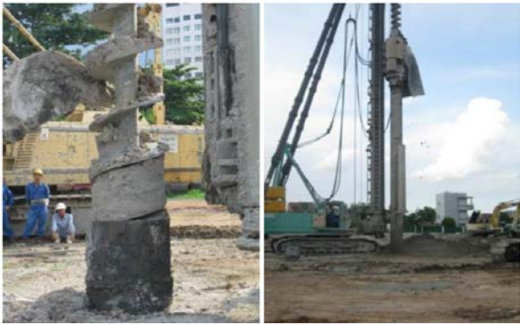
Hình 5. Thi công cọc bằng phương pháp BASIC® tại bệnh viện Quốc tế Đồng Nai.
