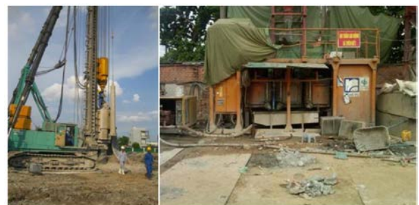
Hình 4. Thiết bị thực tế thi công cọc (máy khoan hạ cọc, máy trộn bơm vữa xi măng).
