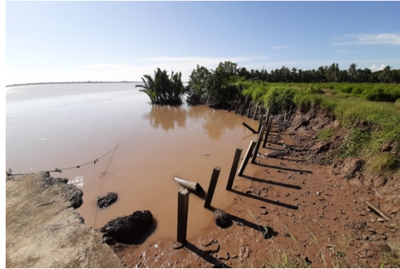
Hình 2. Hình ảnh sạt lở do sóng của tàu cao tốc đánh lấn sâu vào bờ khoảng 20m.
