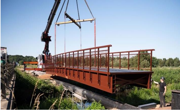
Hình 1. Sử dụng vật liệu PFRP vào cầu đường bộ (cung cấp bởi công ty Fiberline Building Profiles A/S).
