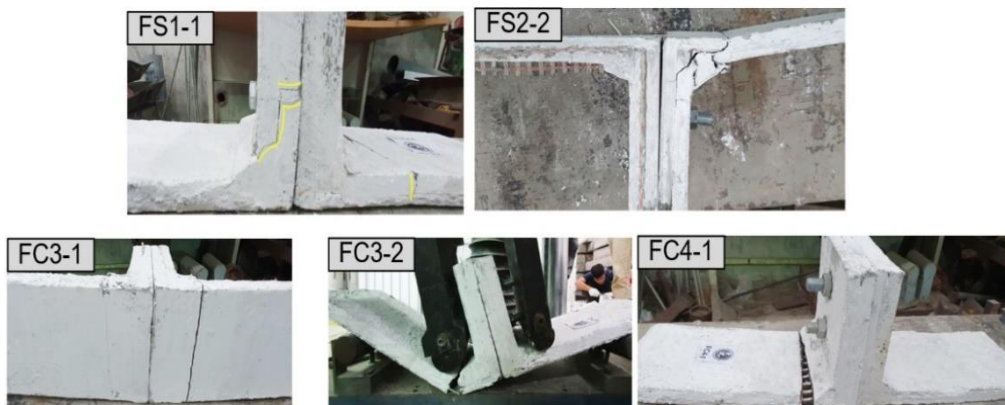
Hình 9. Cấu trúc vết nứt của một số mẫu thí nghiệm liên kết chịu uốn.
