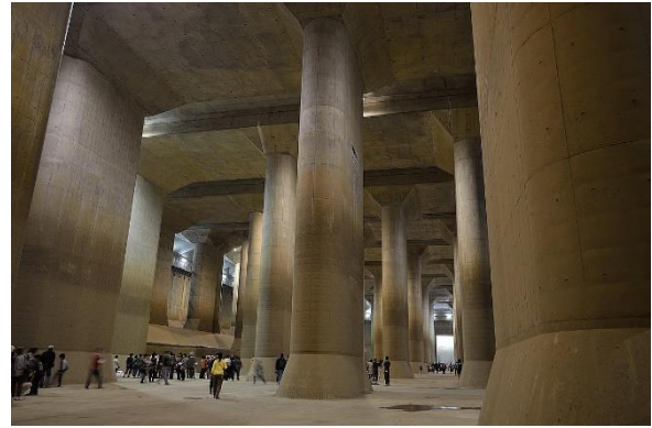
Hình 2. Hệ thống G-cans được mở cửa đón khách tham quan khi hết mùa mưa bão [6].
