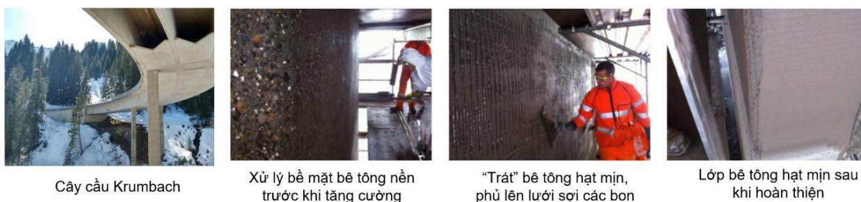
Hình 1. Ứng dụng BTCLD để sửa chữa cầu Krumbach ở Vorarlberg (Áo).
